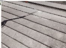
屋根 高圧洗浄
